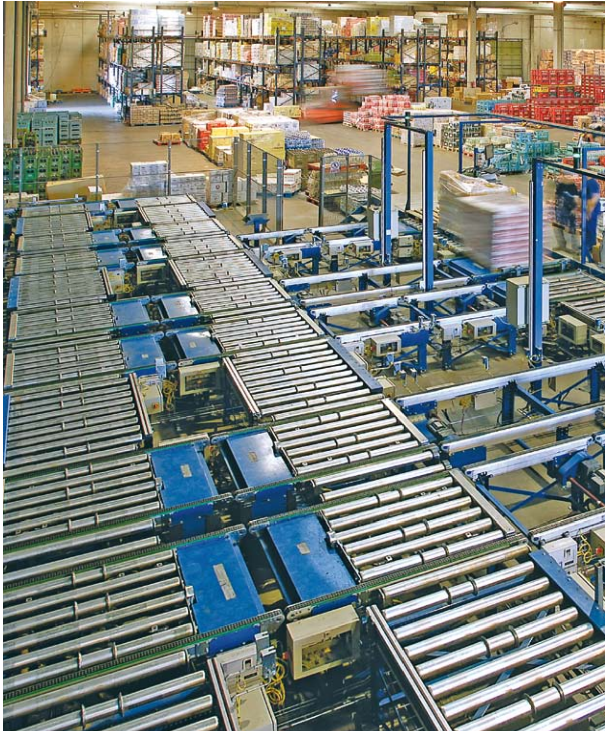
En primer lugar, cabecera de un almacén automático y, al fondo, un almacén convencional. Fuente: Mecalux.
