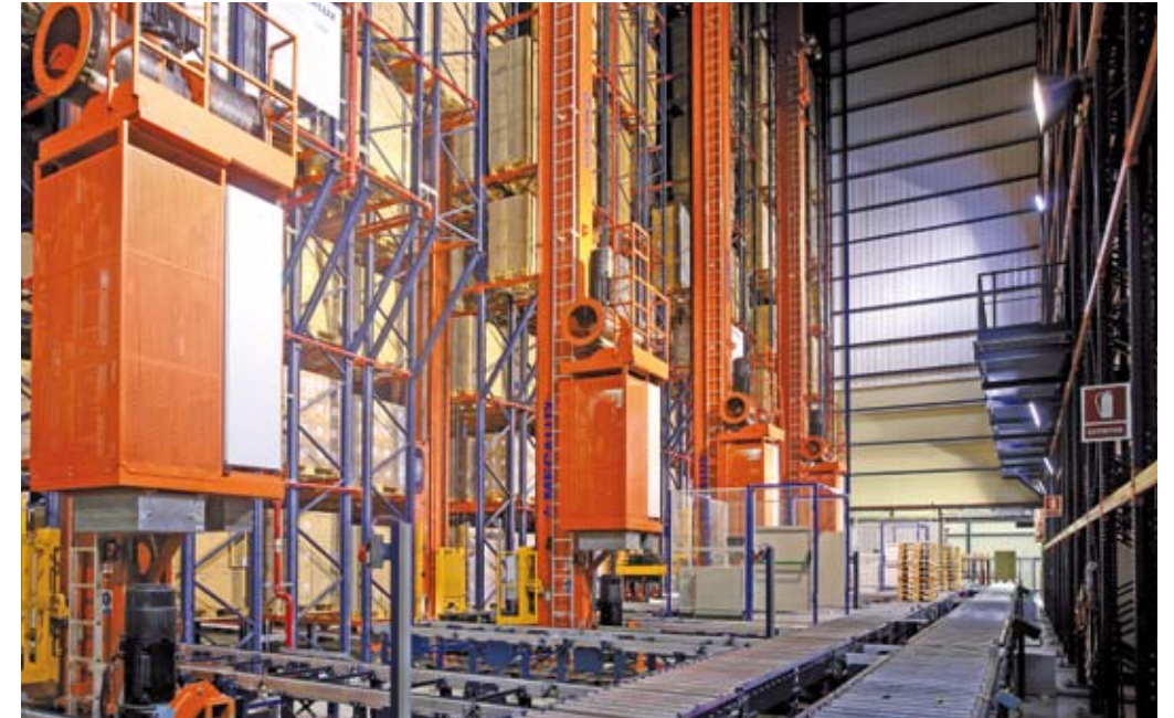
Almacén para empresa dedicada a la fabricación y distribución de tecnología sanitaria. Fuente: Mecalux.
