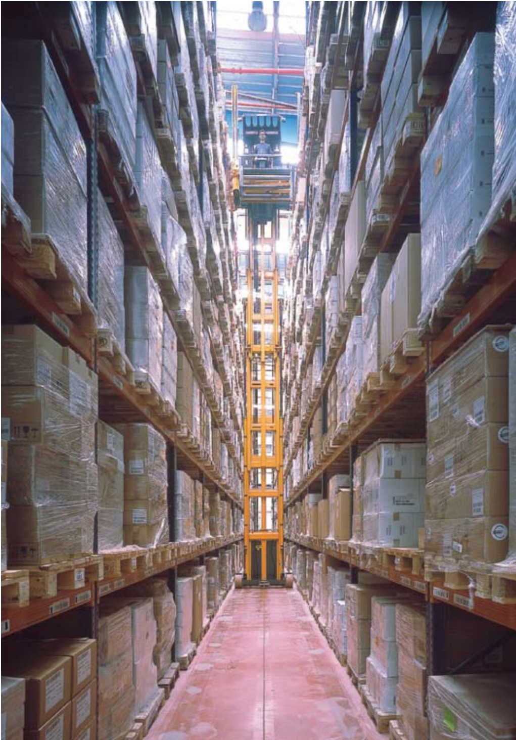
Almacén dedicado a la logística de la industria farmacéutica servido por trilaterales. Fuente: Mecalux.
