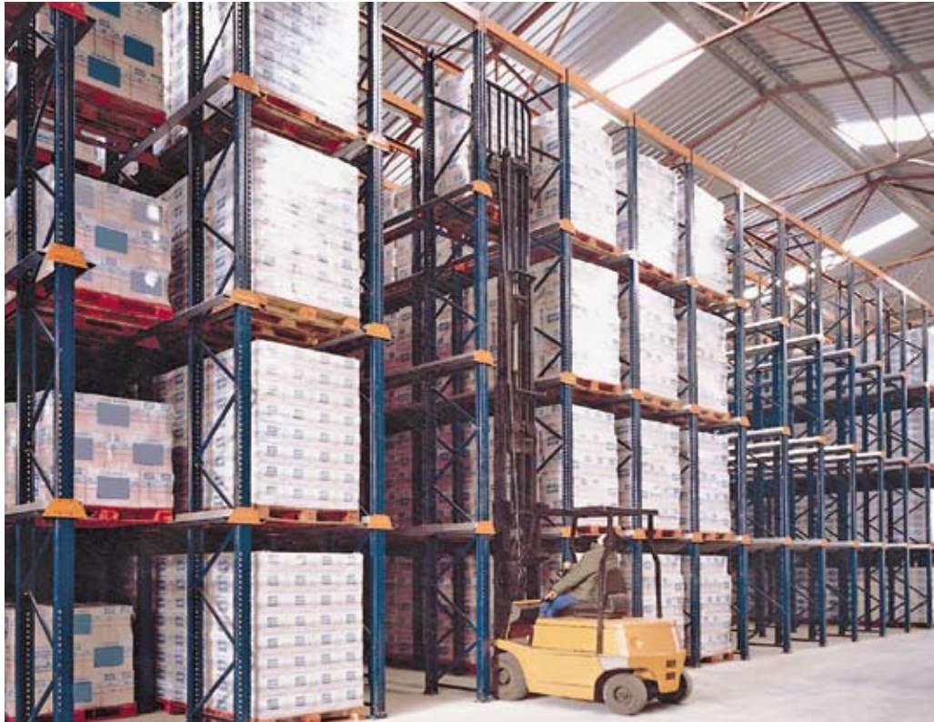
Almacén/cámara frigorífica dedicada al almacenaje de carnes y otros productos alimentarios. Fuente: Mecalux.
