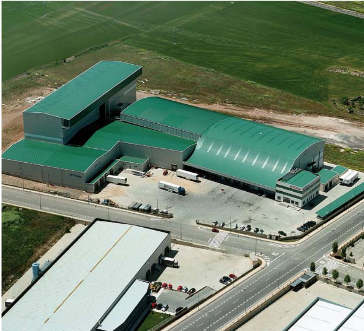
Almacén dedicado a la logística de productos alimentarios refrigerados y congelados. Fuente: Mecalux.
