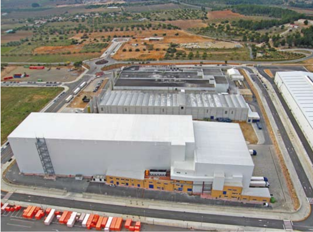
Almacén central dedicado a la producción y distribución de masas congeladas para el sector de la alimentación. Fuente: Mecalux.
