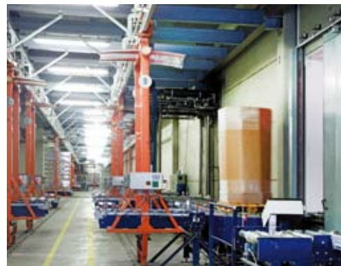
Almacén para fábrica de productos congelados. Fuente: Mecalex.
