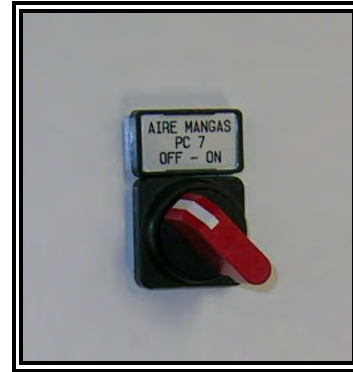
Figura 5-13 Selector neumático para el cambio de manga
